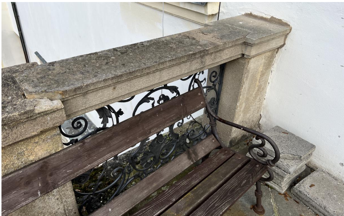
Jižní zábradlí terasy s novým betonovým sloupkem a novou betonovou částí madla (novodobé doplňky po odstranění severního schodiště)
