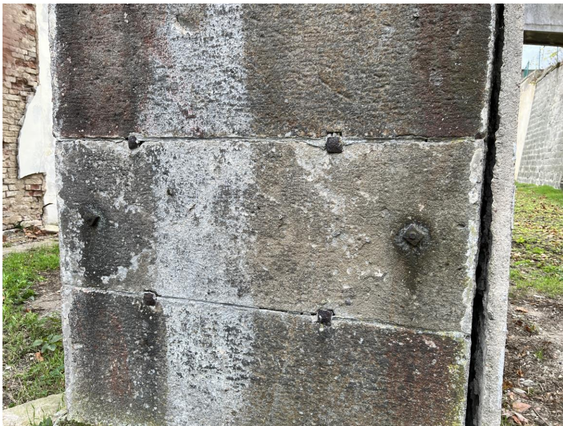
Detail kamenného obkladu pilíře a odtržené sanační omítky
