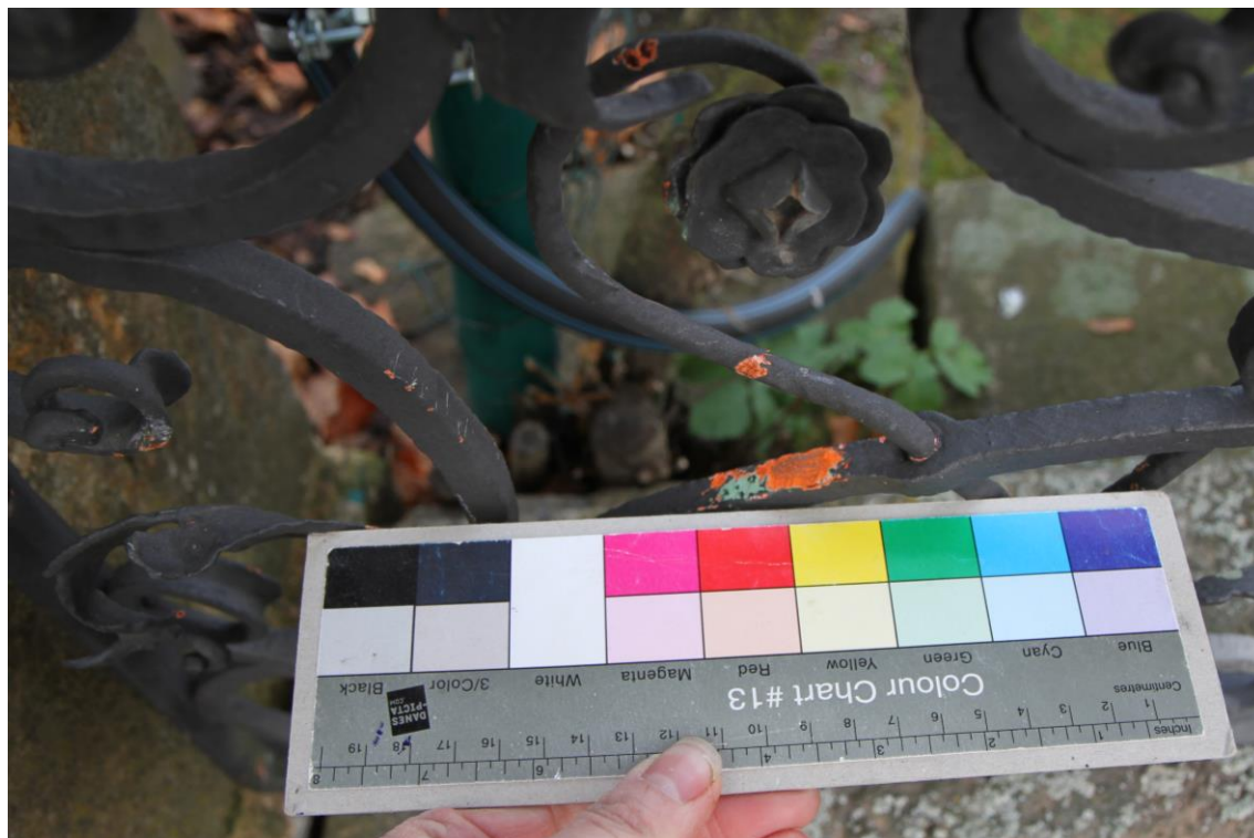
Průzkum barevnosti kované části zábradlí-na povrchu železa oranžový základní (snad suříkový) nátěr, následuje vrstva zeleného nátěru a současný černý nátěr.
