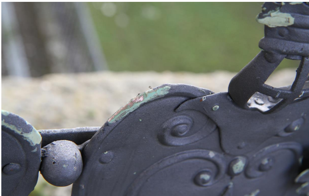
Průzkum barevnosti tepané výzdoby zábradlí – na měděném plechu zelený nátěr, následuje současný černý nátěr
