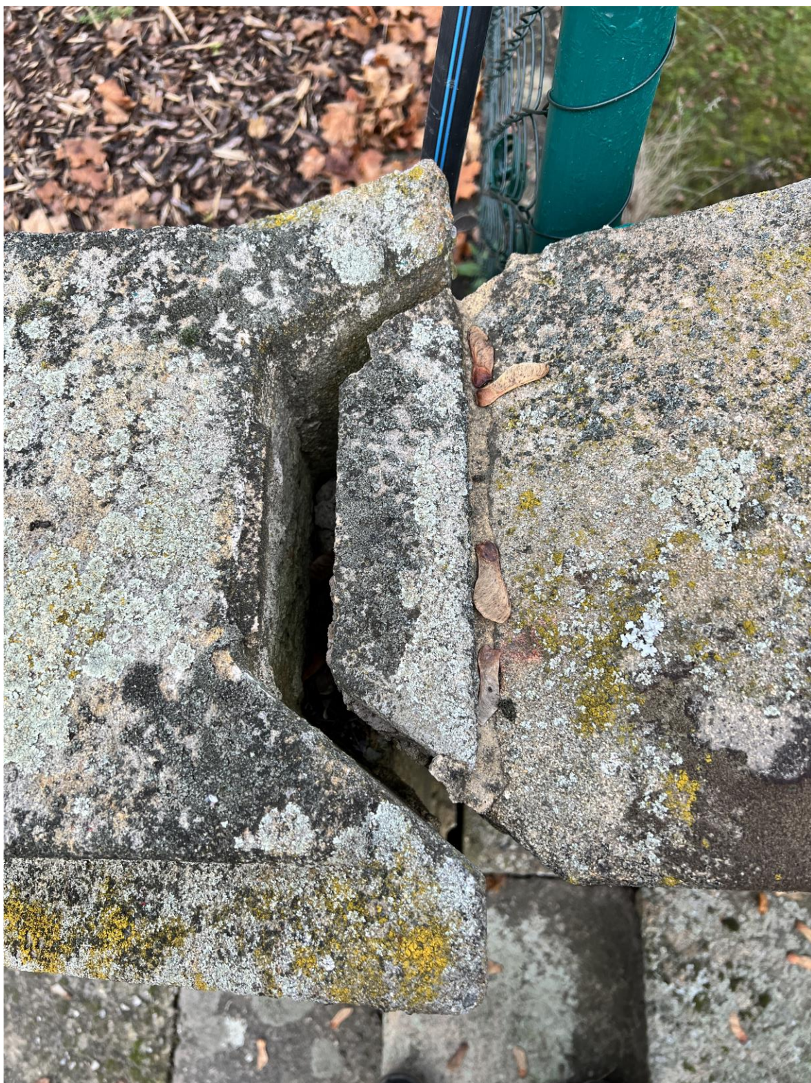
Rozestoupený kamenický zámek mezi madlem zábradlí a spodním sloupkem (severní strana schodiště)
