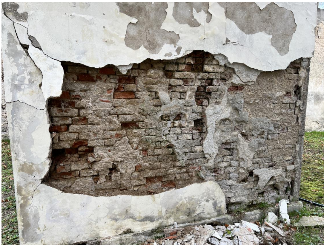
Havarijní stav sanační omítky na vnitřní ploše pilíře
