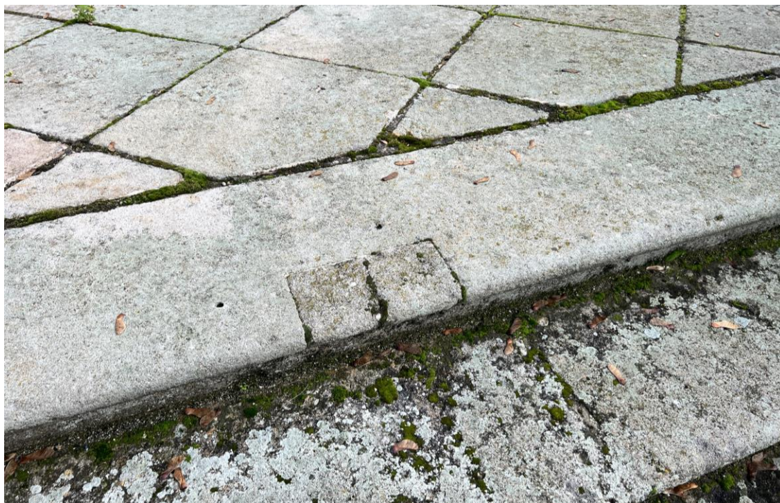
Kamenný doplněk poškozeného nosu horního schodu
