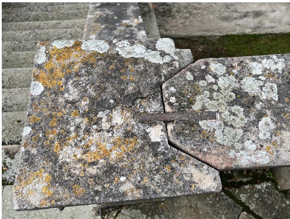
Detail rozestoupeného spoje mezi madlem zábradlí a krajním sloupkem terasy (severní strana)
