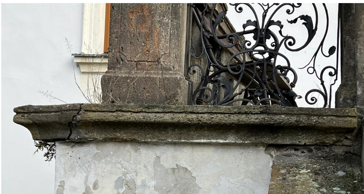
Detail poškození římsy po obvodu terasy
