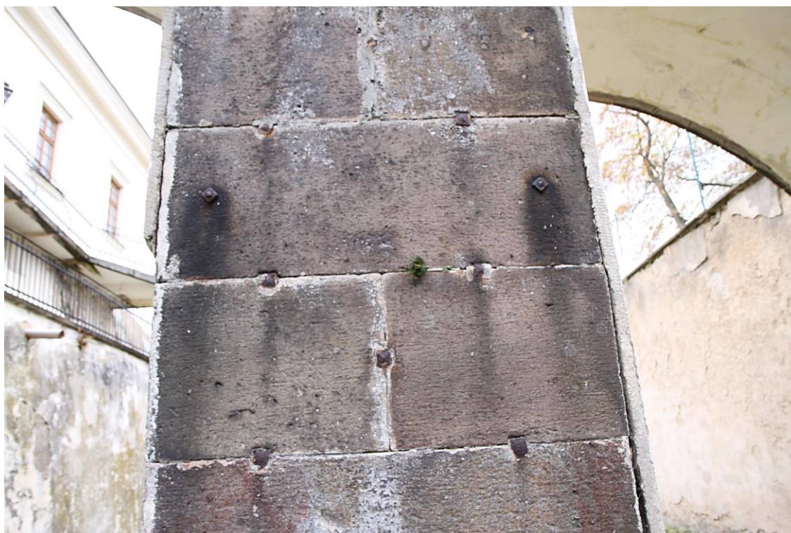
Detail kamenného obkladu pilíře a odtržené sanační omítky
