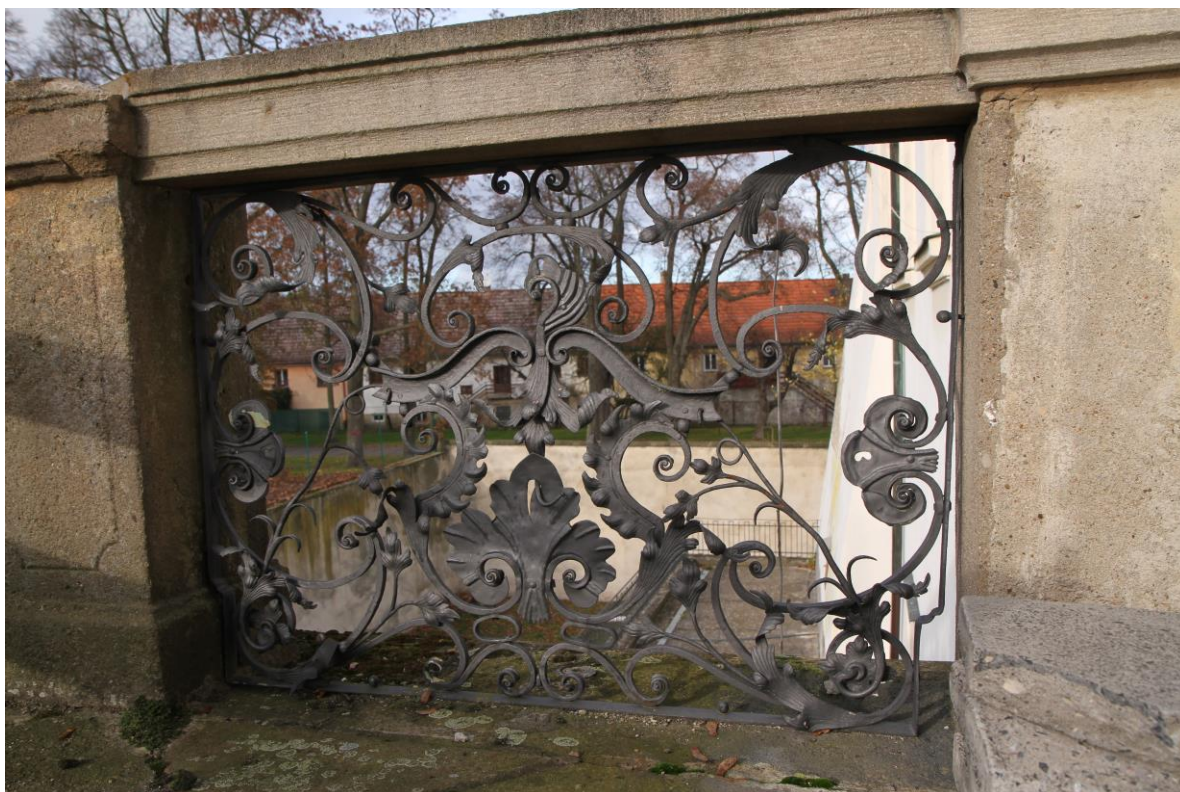
Jižní zábradlí terasy s novým betonovým sloupkem a novou betonovou částí madla (novodobé doplňky po odstranění severního schodiště)
